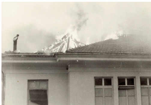
L'incendio nelle scuole
